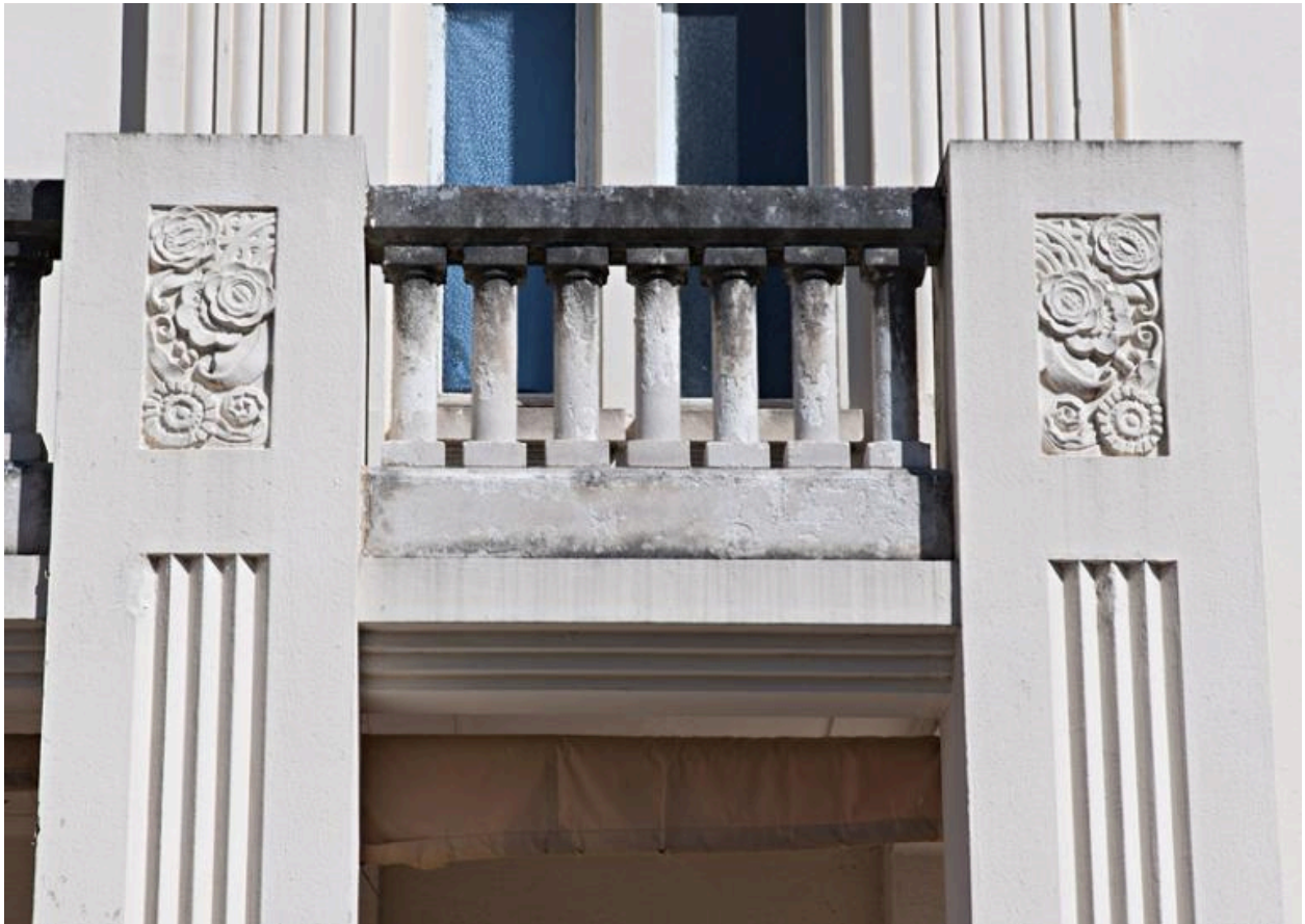
Hôtel-Dieu de Clermont-Ferrand. La polyclinique, façade principale, détail du décor du porche de l'entrée principale.
