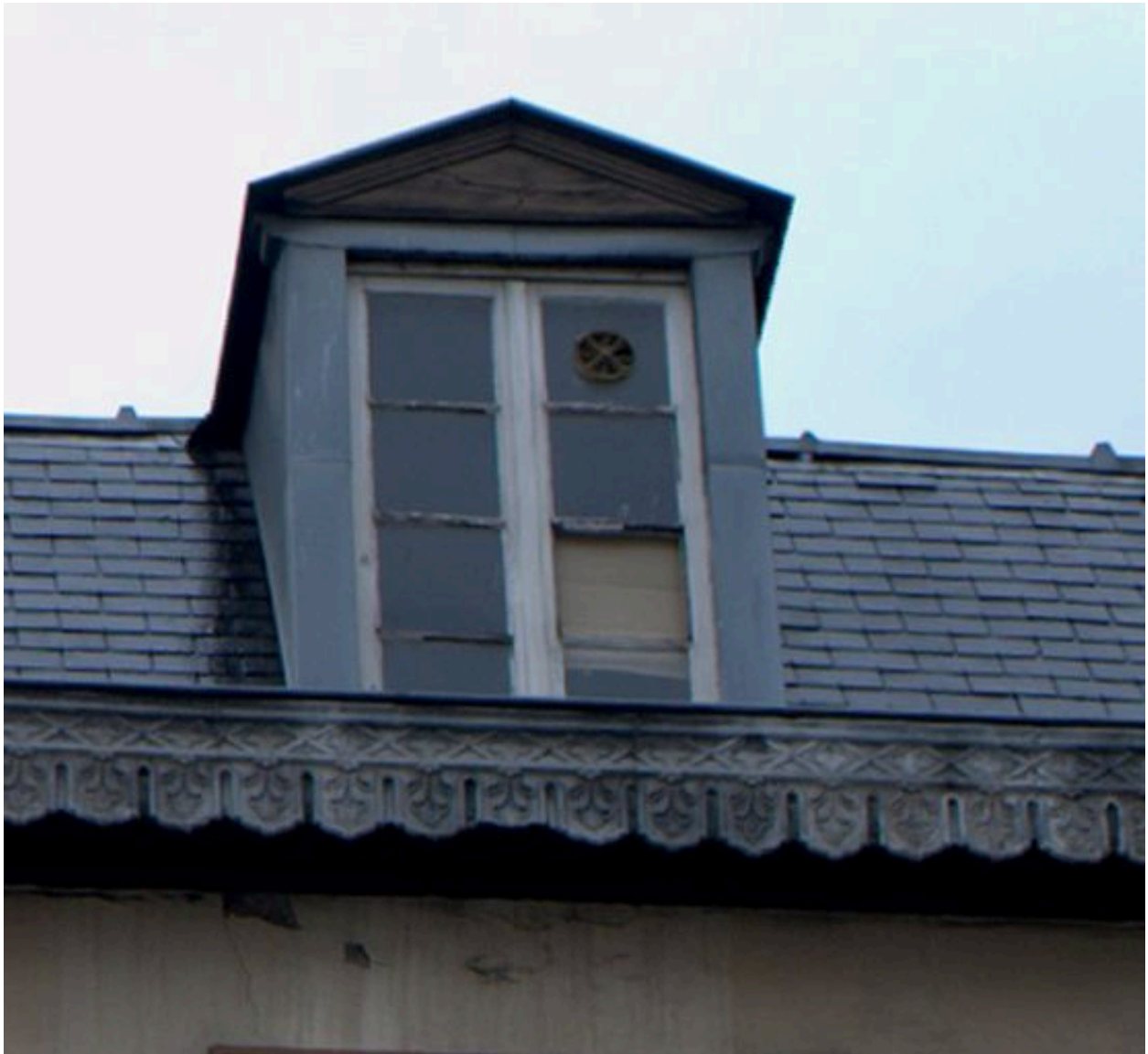
Détail d'une lucarne et de la rive de toit
