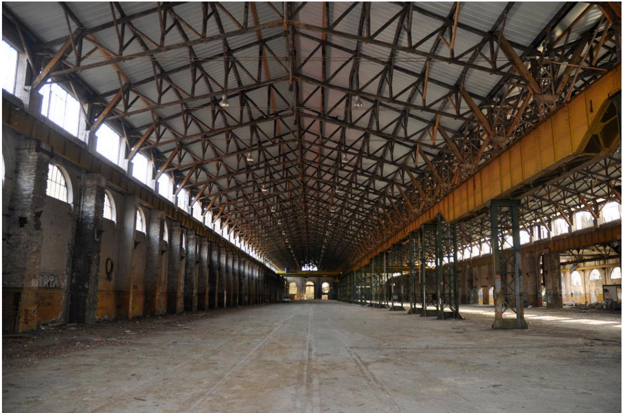
Détail charpente en bois
