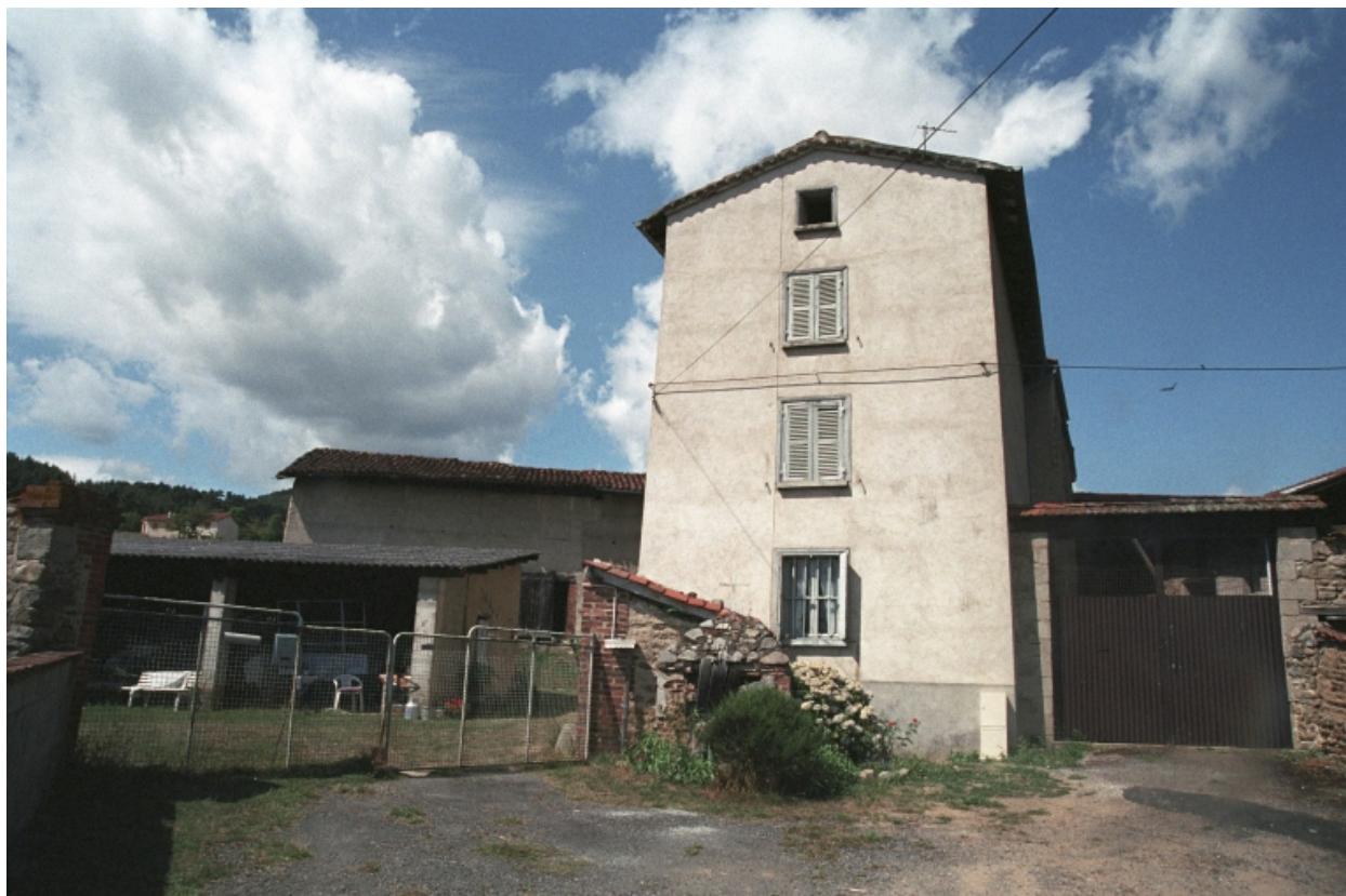
Culvé, ferme, vue d'ensemble (1986 A 464).
