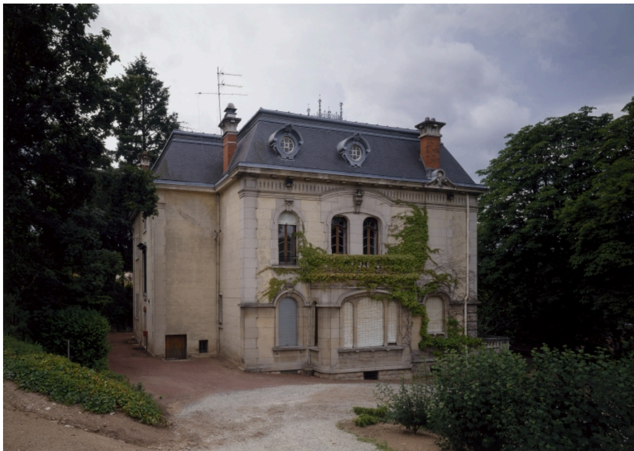
Vue générale de la façade nord.
