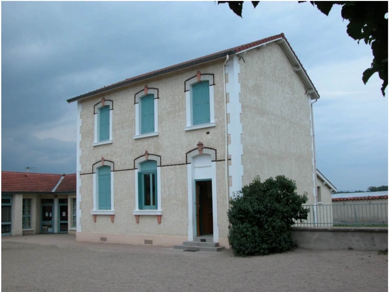
Vue d'ensemble de la façade sur cour.
