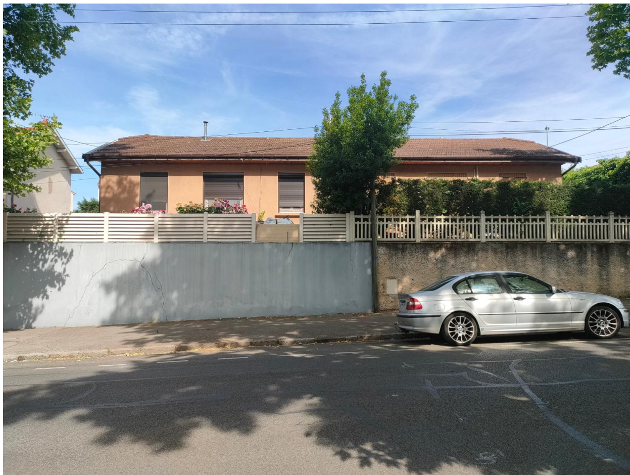
Maisons des cadres de l'ancienne usine Maréchal - boulevard Laurent Gérin - mai 2022
