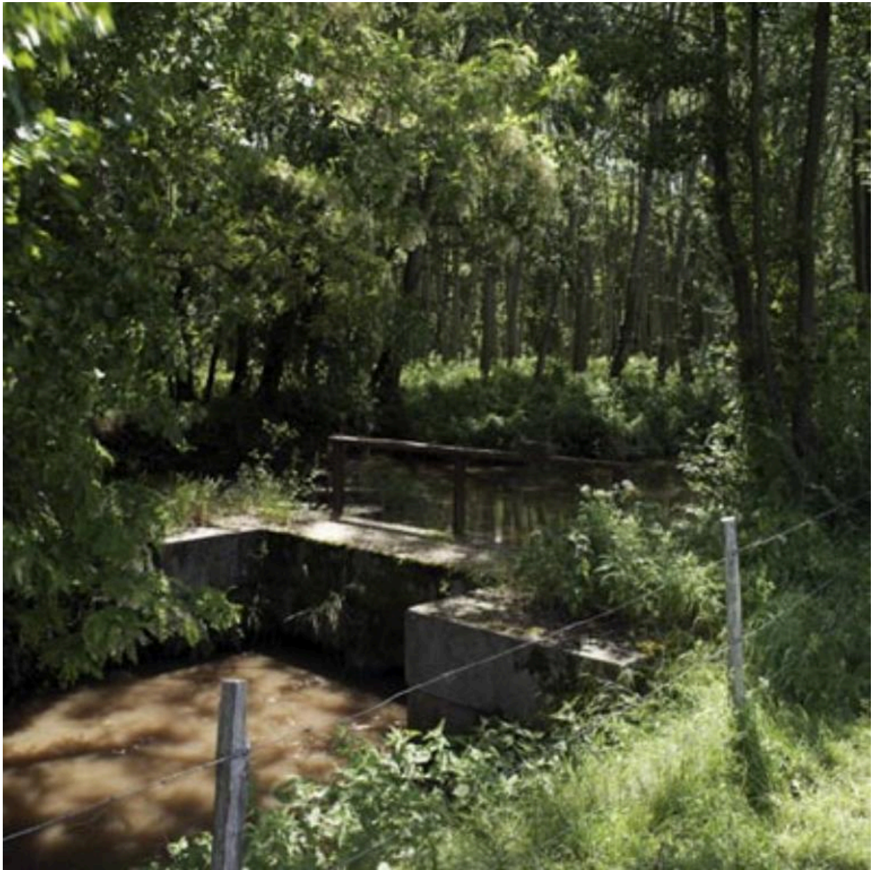
Vue d'ensemble aval de la prise d'eau du bief.
