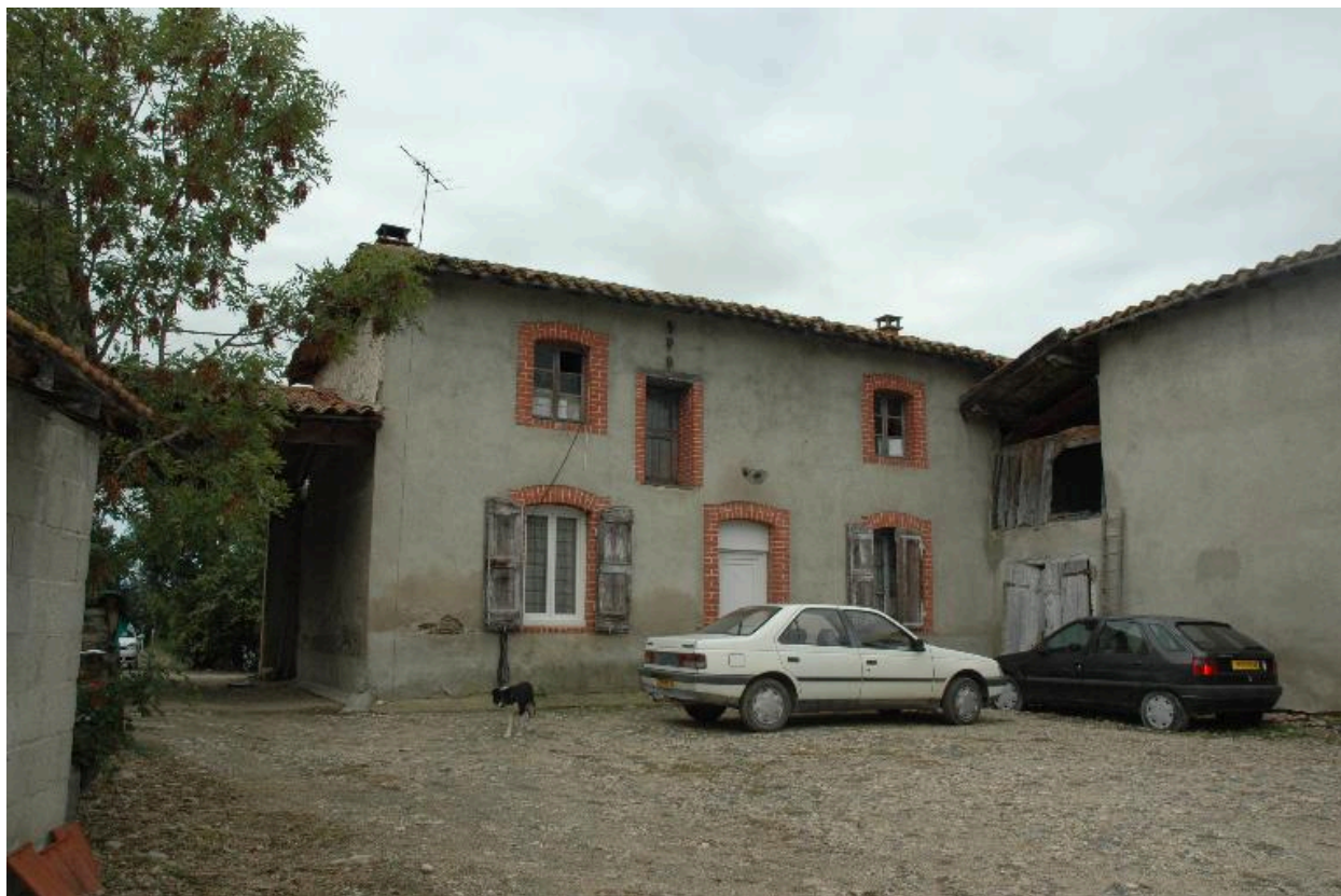
Vue d'ensemble du logis sur cour.
