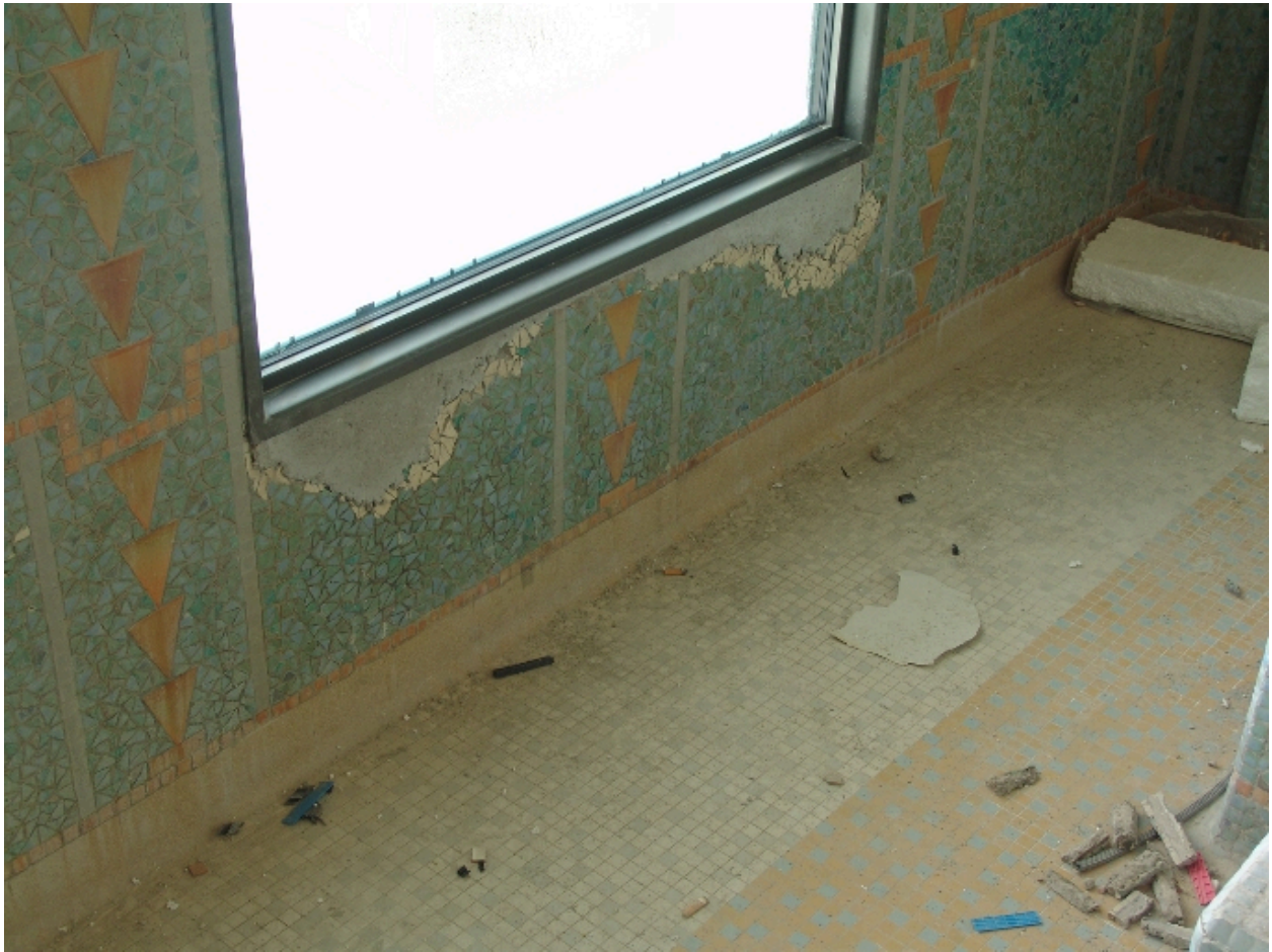
Cabines de luxe lors de la pose des nouvelles fenêtres
