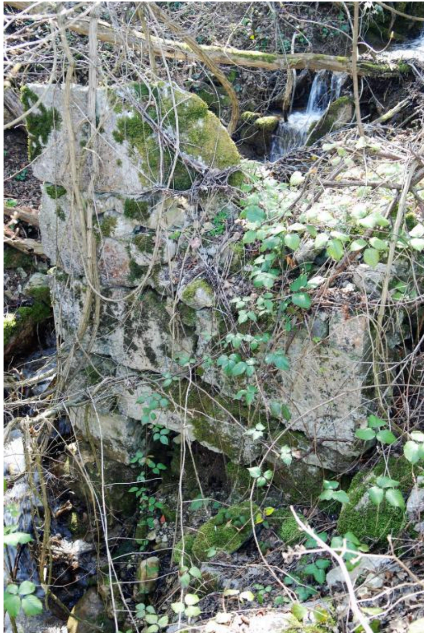
B12 636, Tarets (les), moulin (?). Vues partielles en aval
