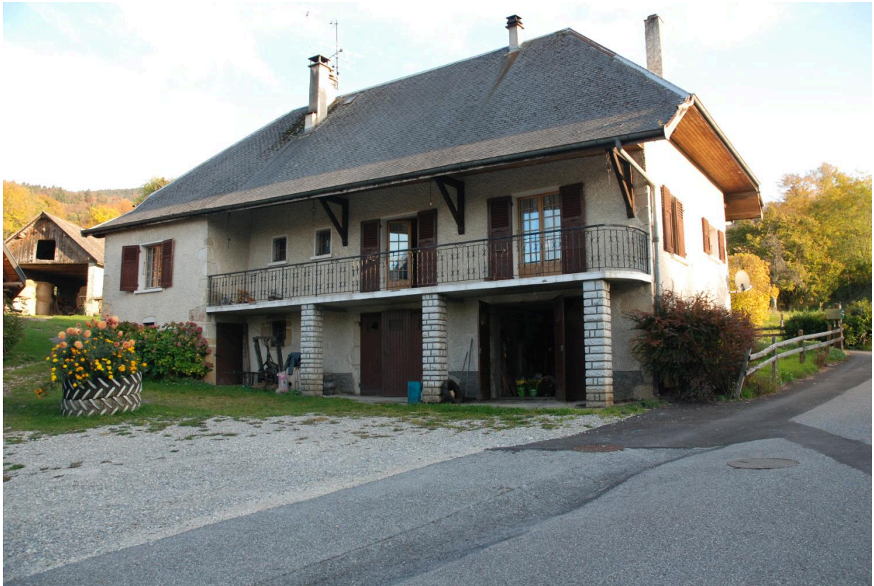
Ferme à juxtaposition puis maison (2017 B52 1152). Vue arrière.
