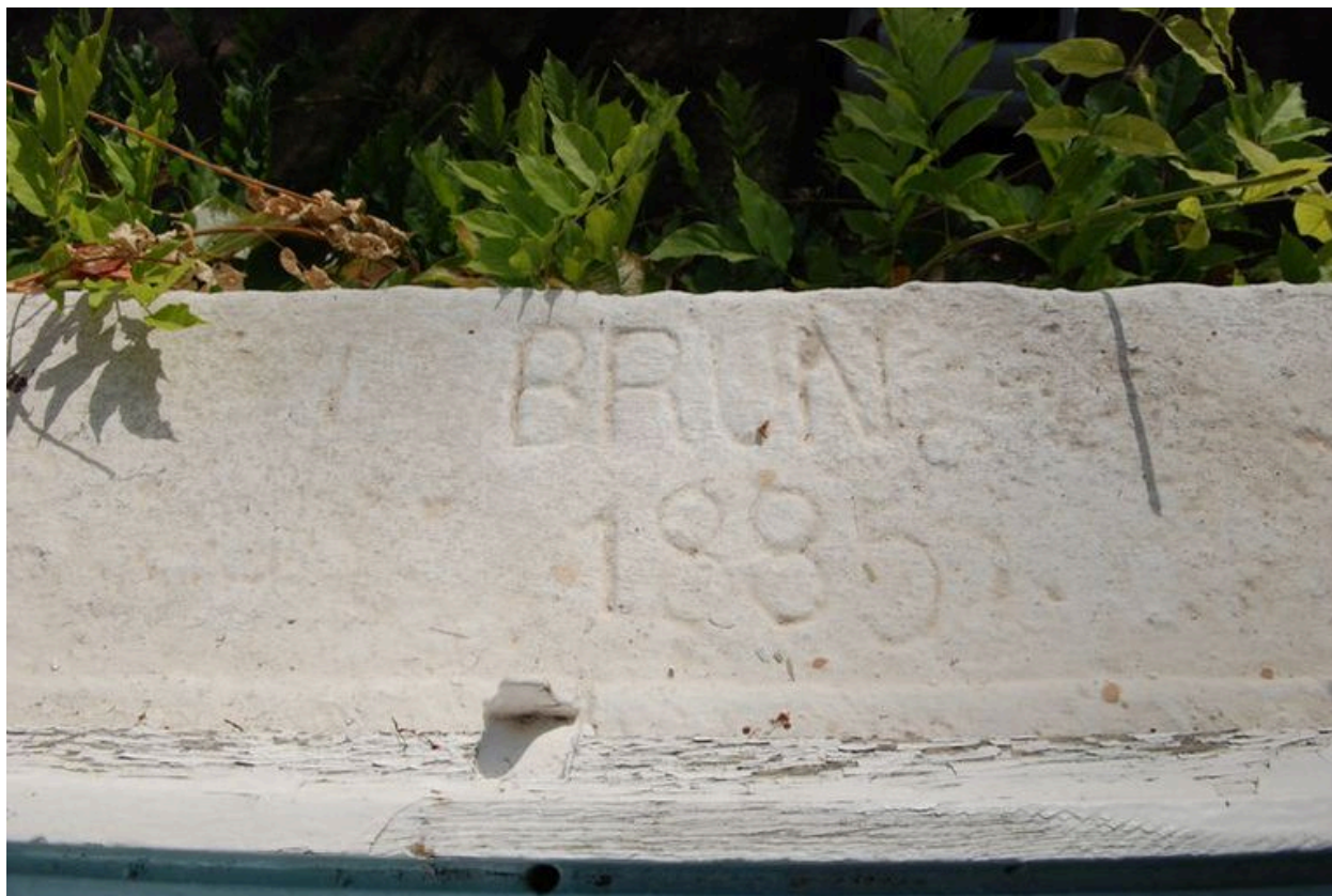
Bâtiment 515, inscription 'Brun 1885' sur un rebord de fenêtre de l'étage
