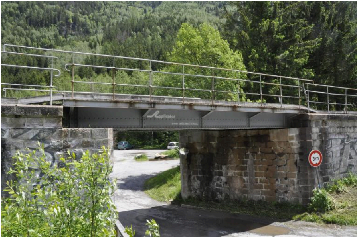
Vue de la face est de l'ouvrage
