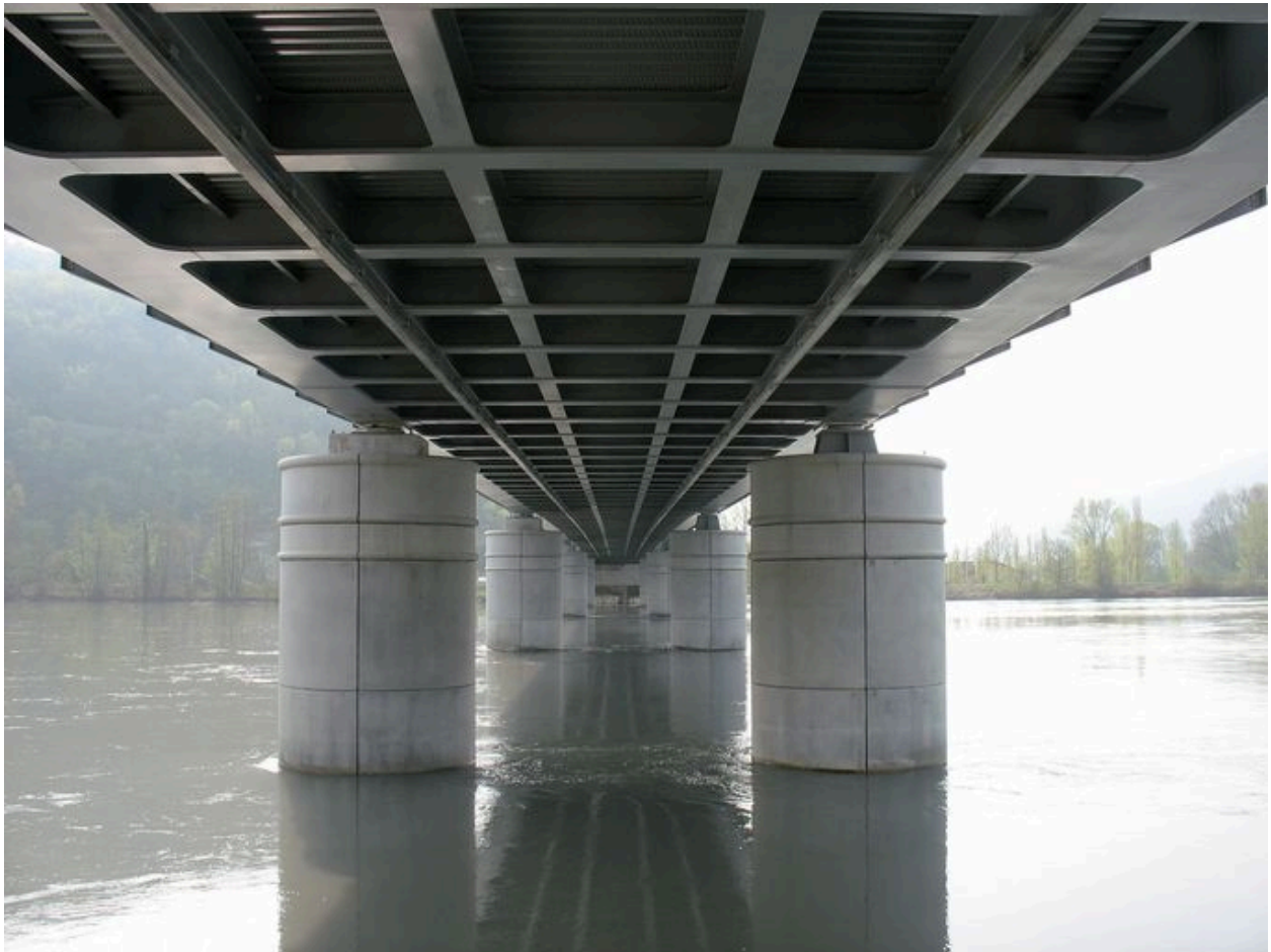
Vue du dessous du tablier
