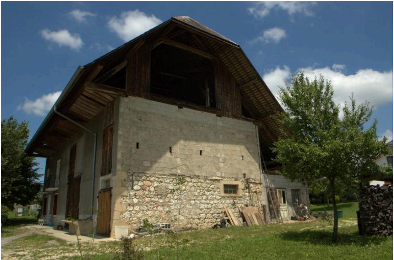
Vue d'ensemble de trois quart avant droit de la ferme.
