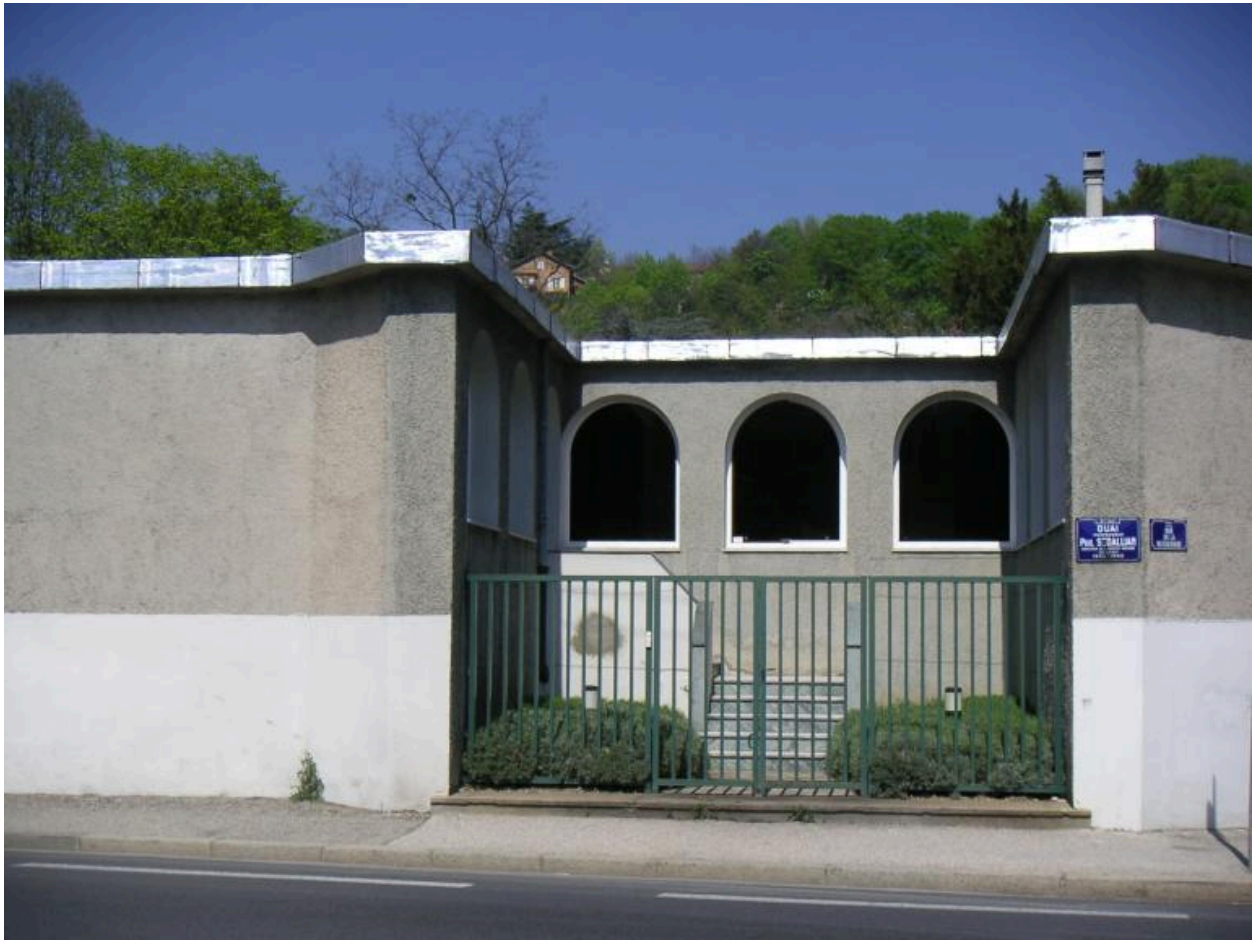
Vue du patio ouvrant sur le quai Paul Sédaillan avant travaux.
