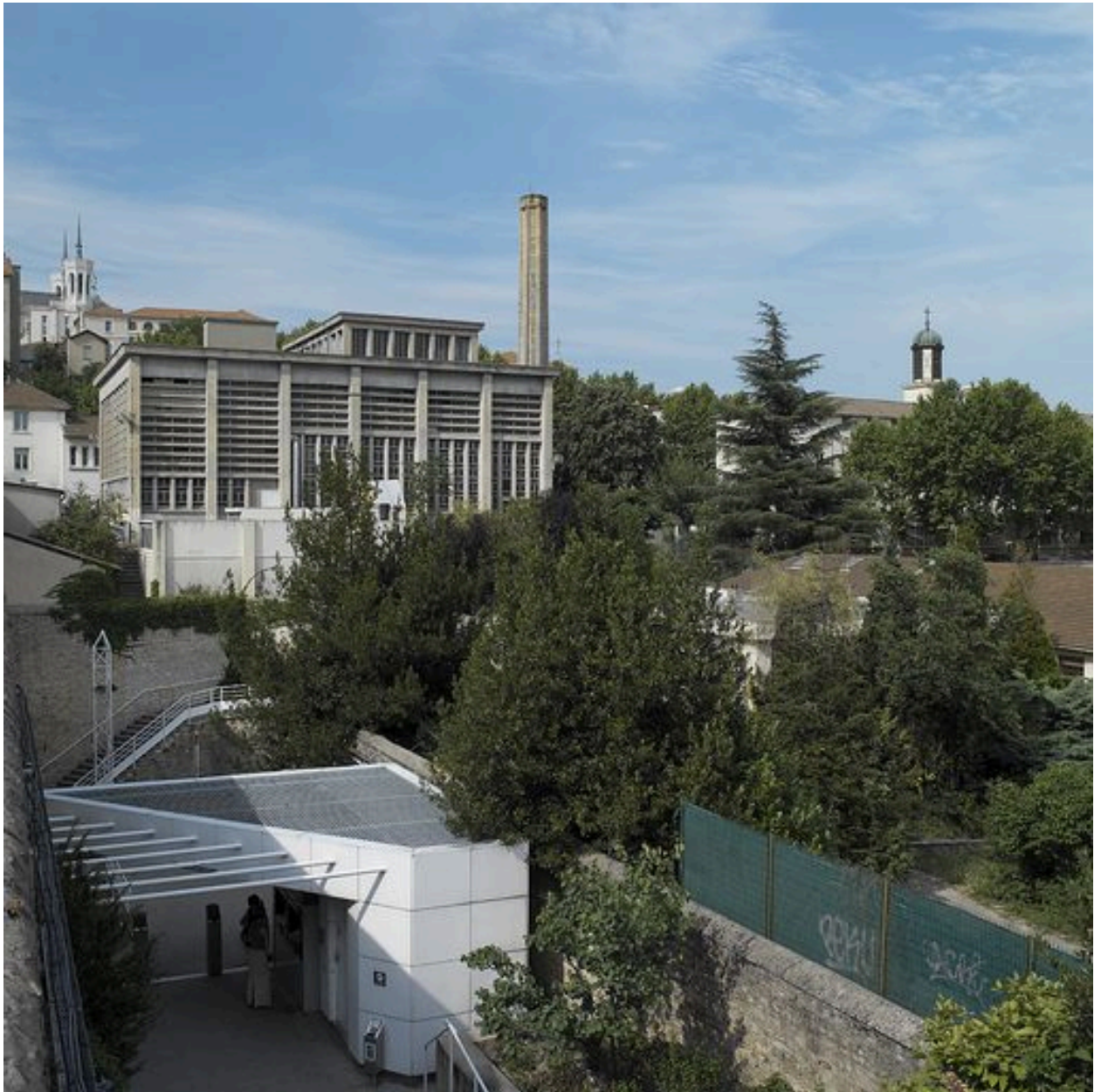
Vue générale de la chaufferie côté sud. Au premier plan, la station du funiculaire et l'ancien jardin potager
