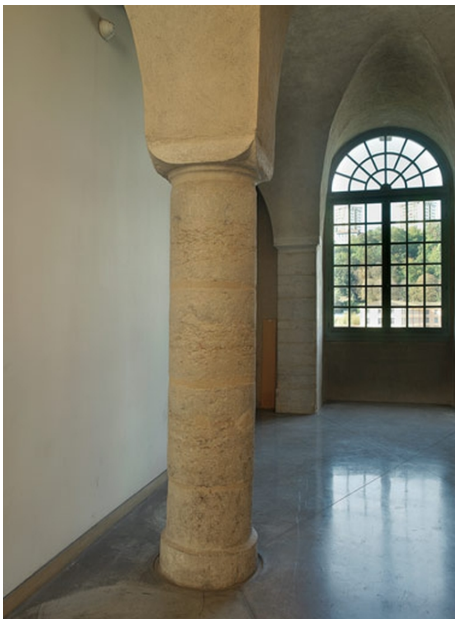
Couloir rez de chaussée aile sud.
