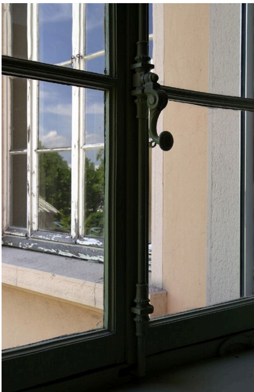
Premier étage : détail d'une espagnolette
