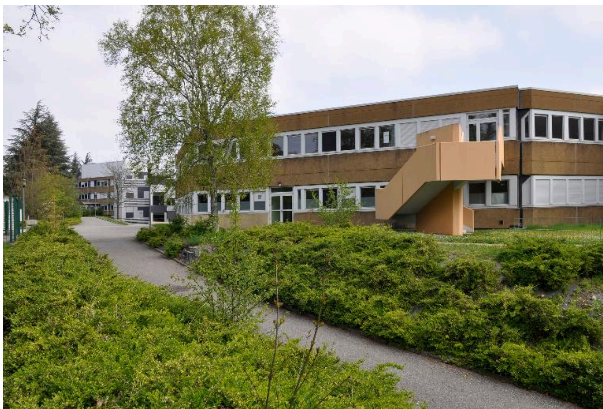
Bâtiment A, élévation ouest
