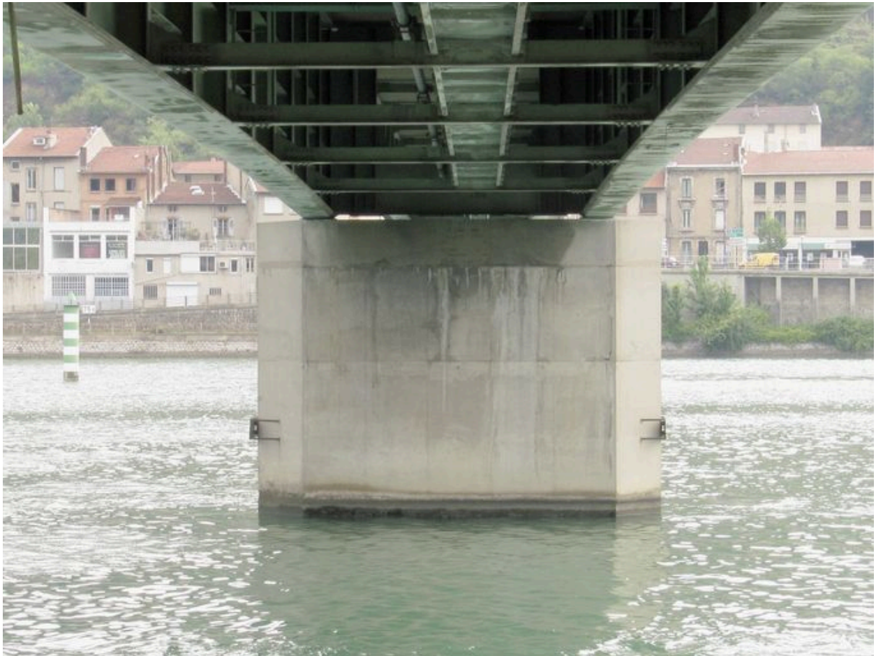
Vue partielle, de dessous, pile et tablier (depuis la rive droite)
