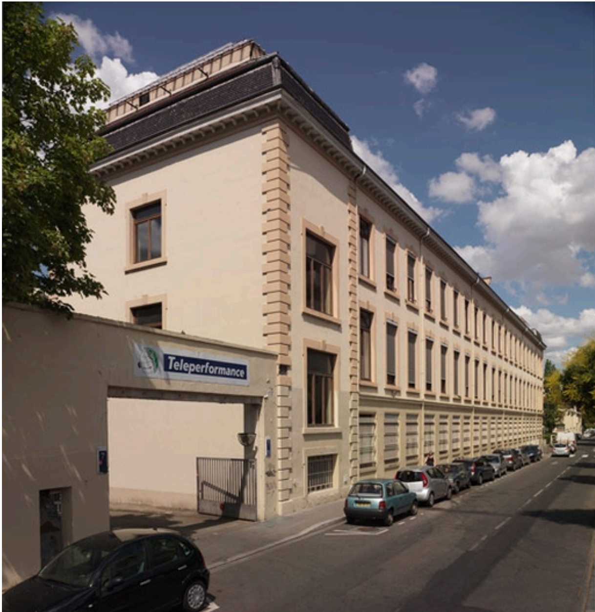
Vue d'ensemble façade principale sur rue
