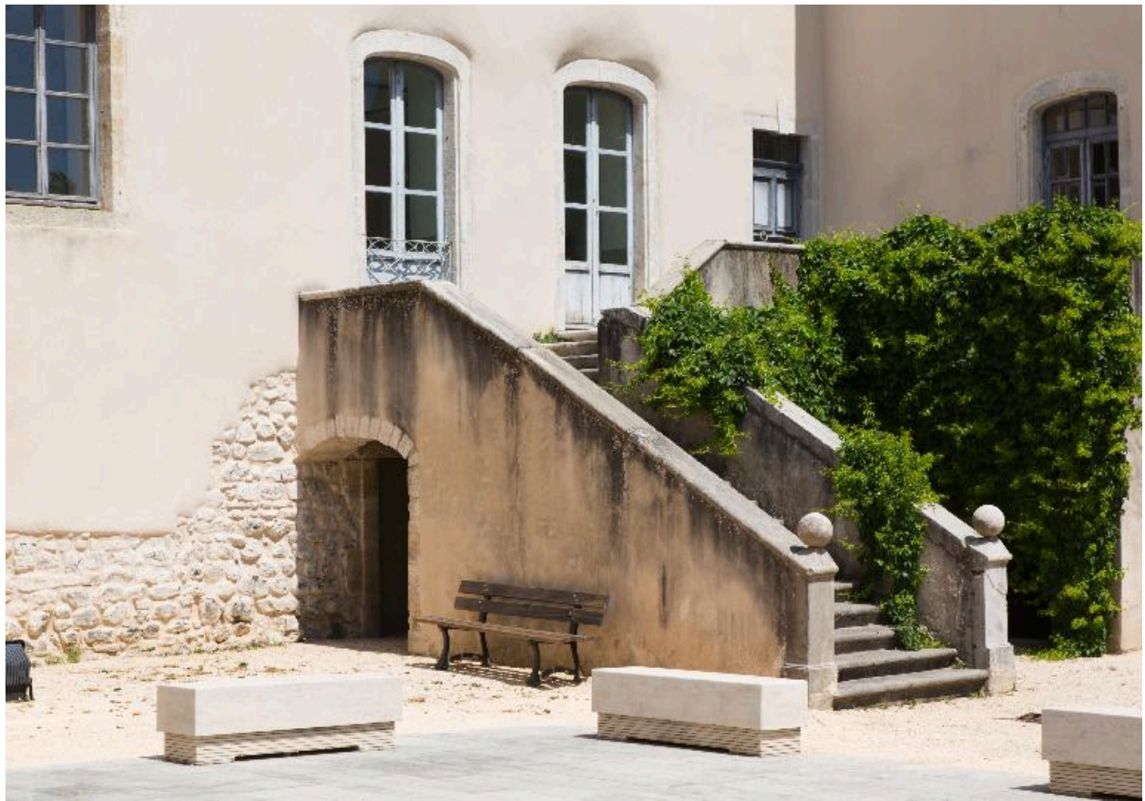
Bastide : cour intérieure, escalier en équerre
