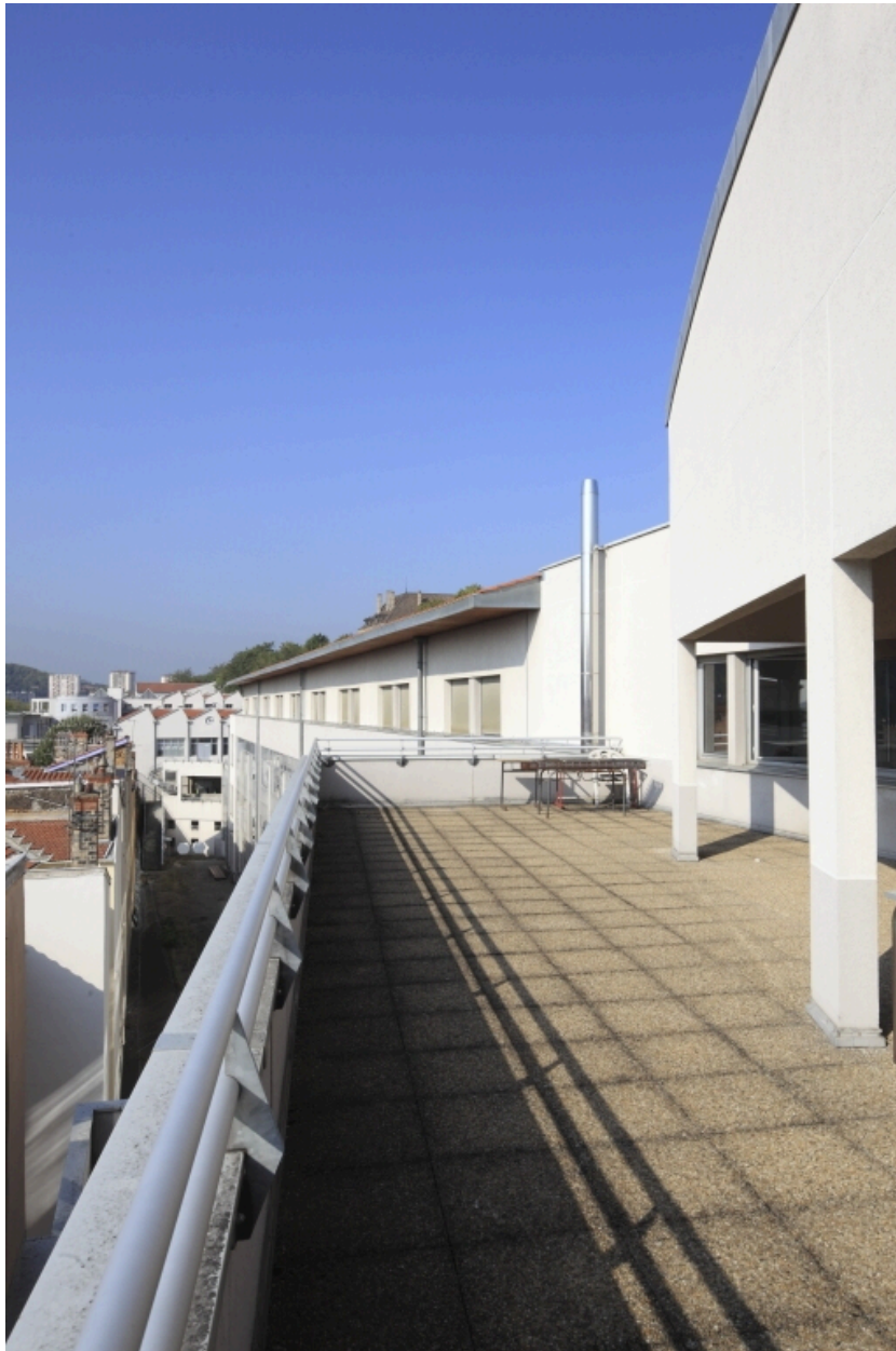
Terrasse du bâtiment des ateliers.
