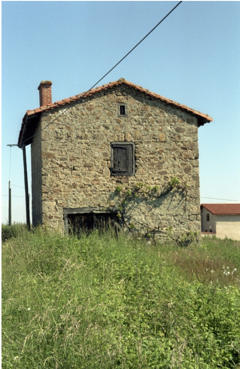
Marcilly-le-Châtel, Le Poyet (1987 C1 394). Loge de type E2a2. Vue d'ensemble.
