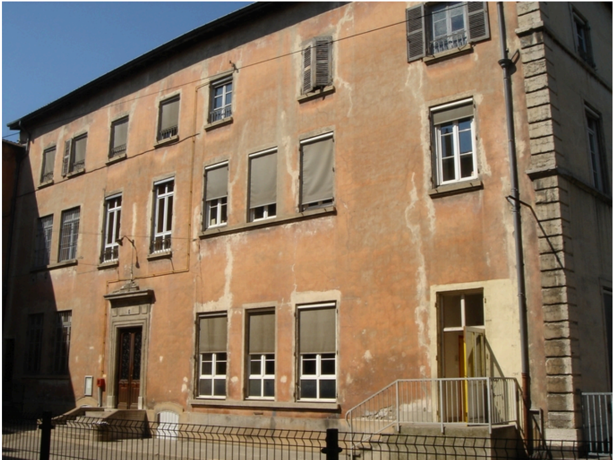
Façade sur cour
