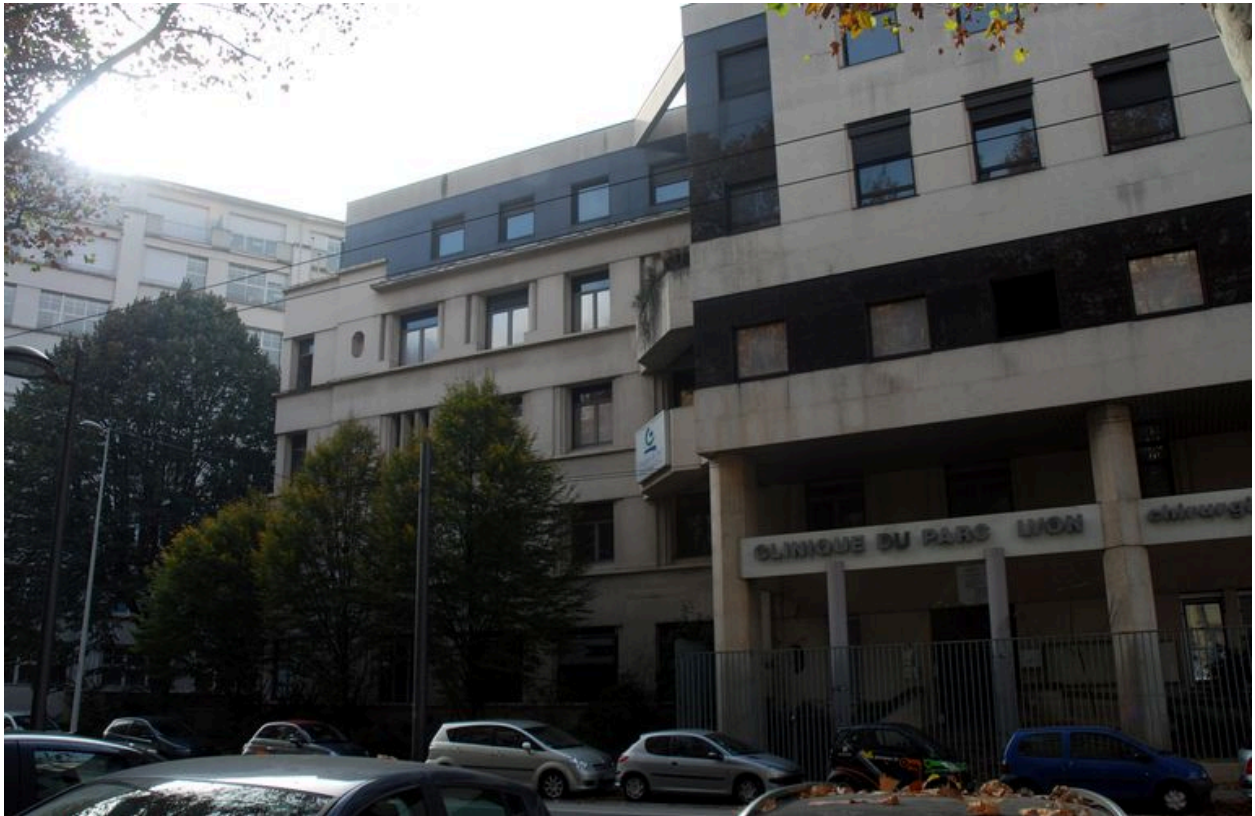
Vue de l'élévation sur le boulevard des Belges.
