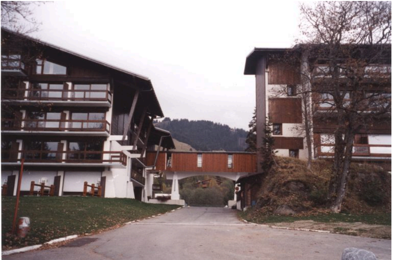
Passerelle entre les deux bâtiments. Etat en 1995
