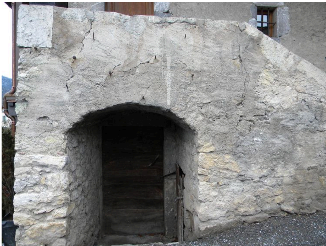
Entrée de cave sous l'escalier extérieur.
