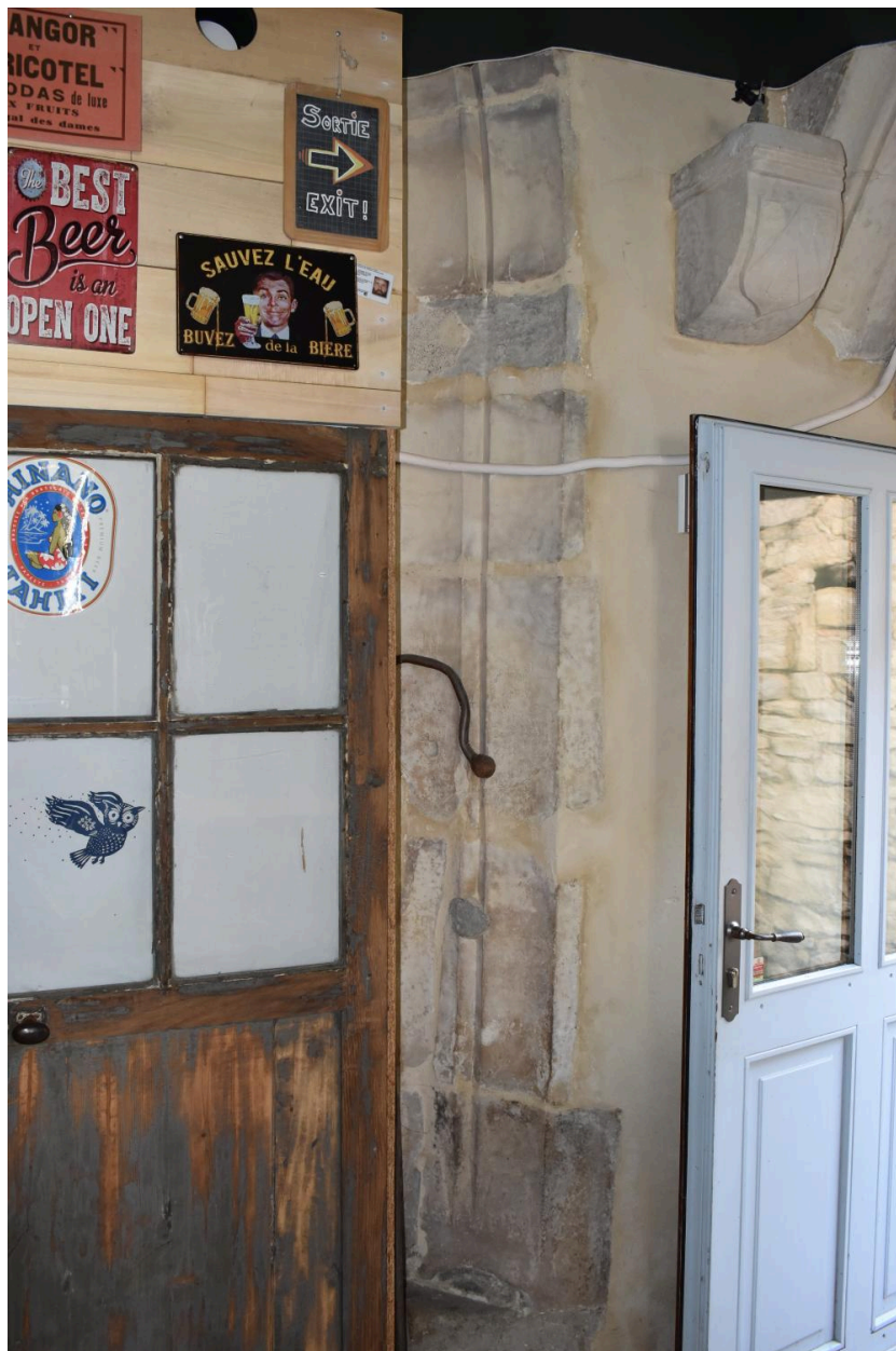
Piédroit de l'arc doubleau de la nef, corbeau et début de l'arc d'accès à la chapelle Alarose détruite.
