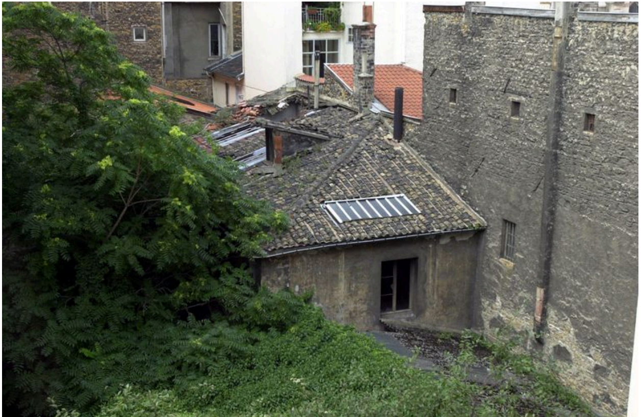
Ateliers, vue générale des toits depuis la cage d'escalier du corps de logis principal
