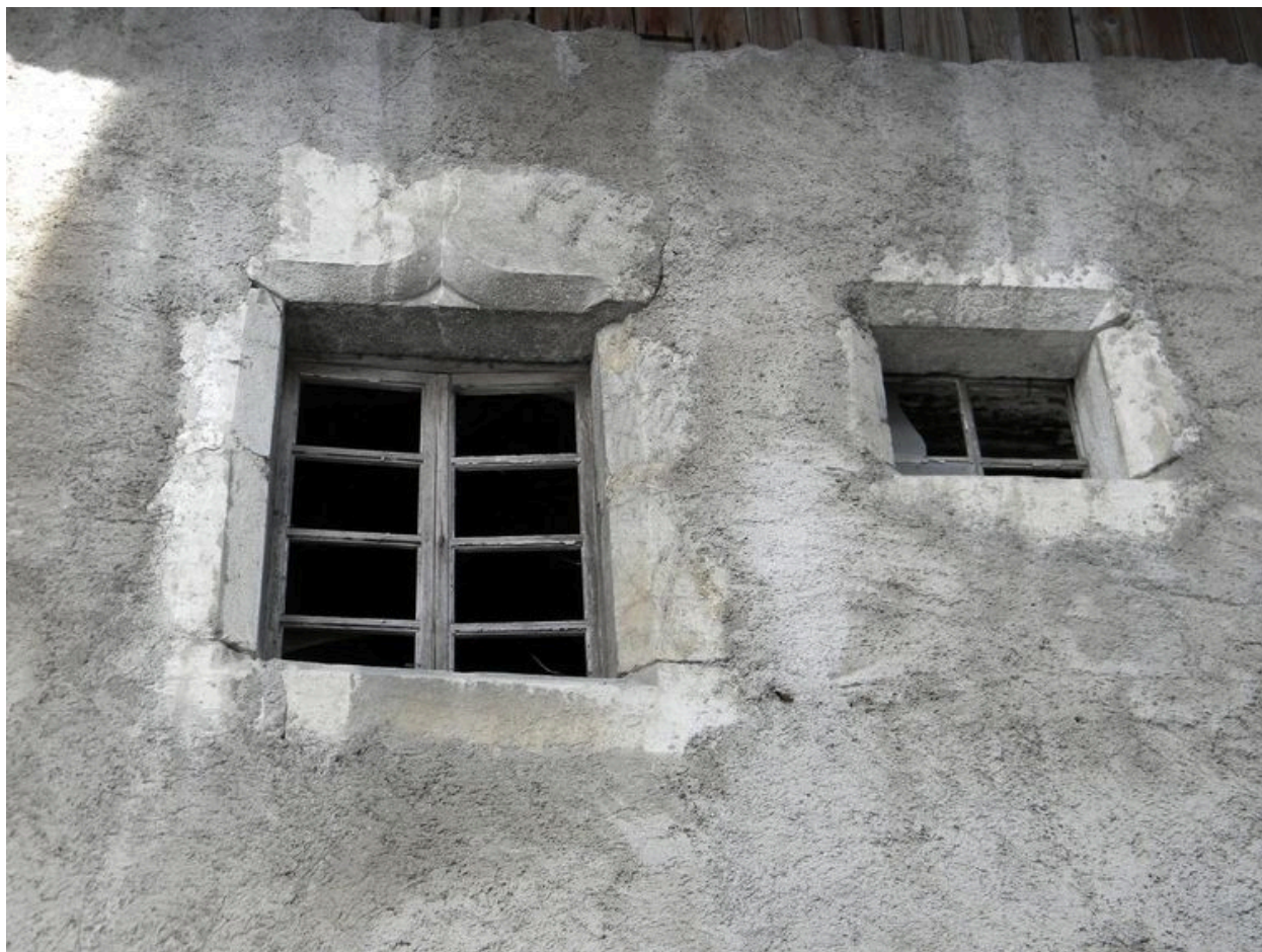
Encadrements de fenêtres en façade principale.
