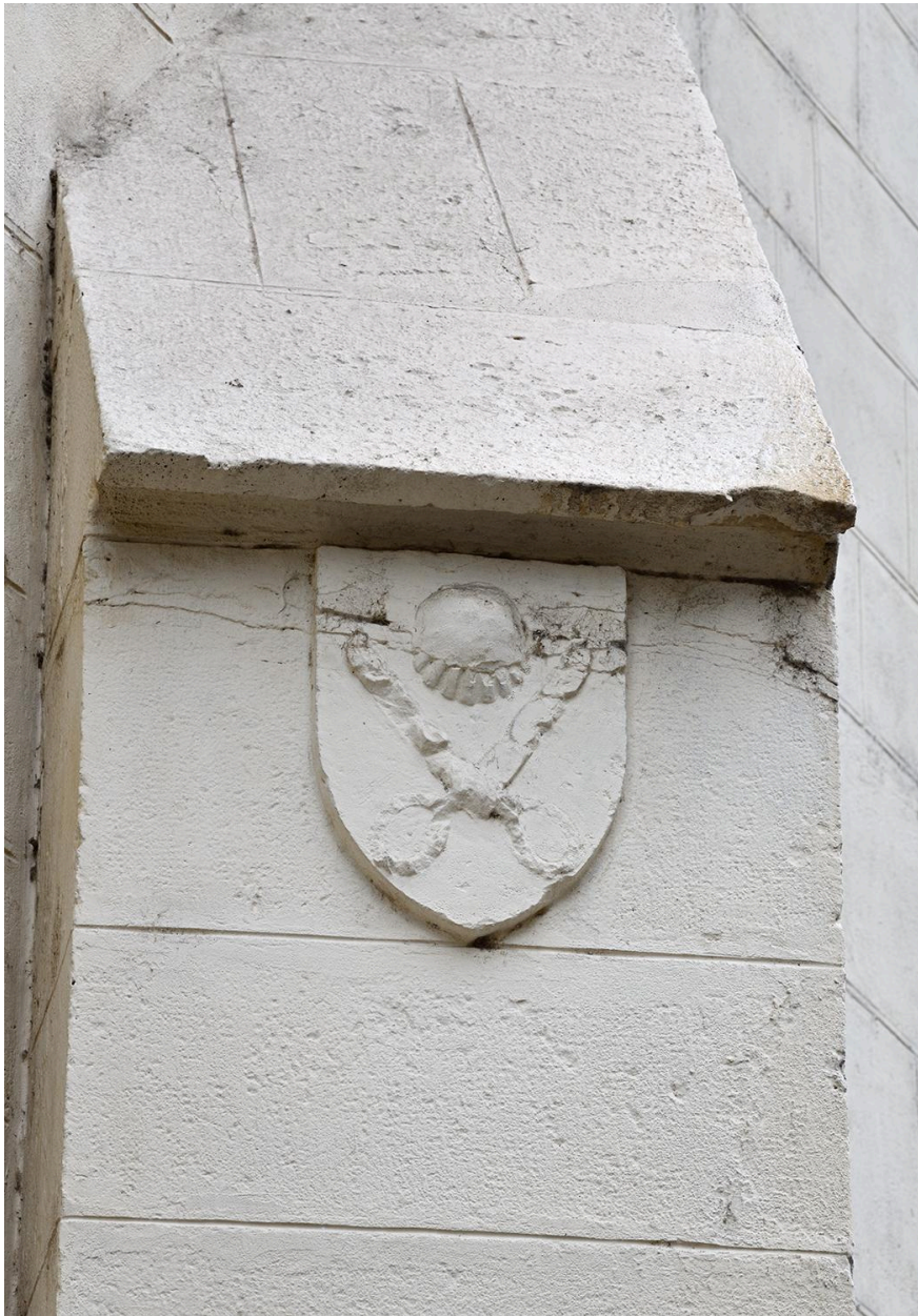
Elévation ouest, contrefort 7, écu portant une coquille et une paire de ciseaux
