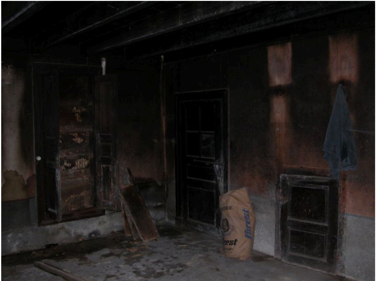
Logis nouveau, cuisine. Vue partielle des murs ouest et nord.
