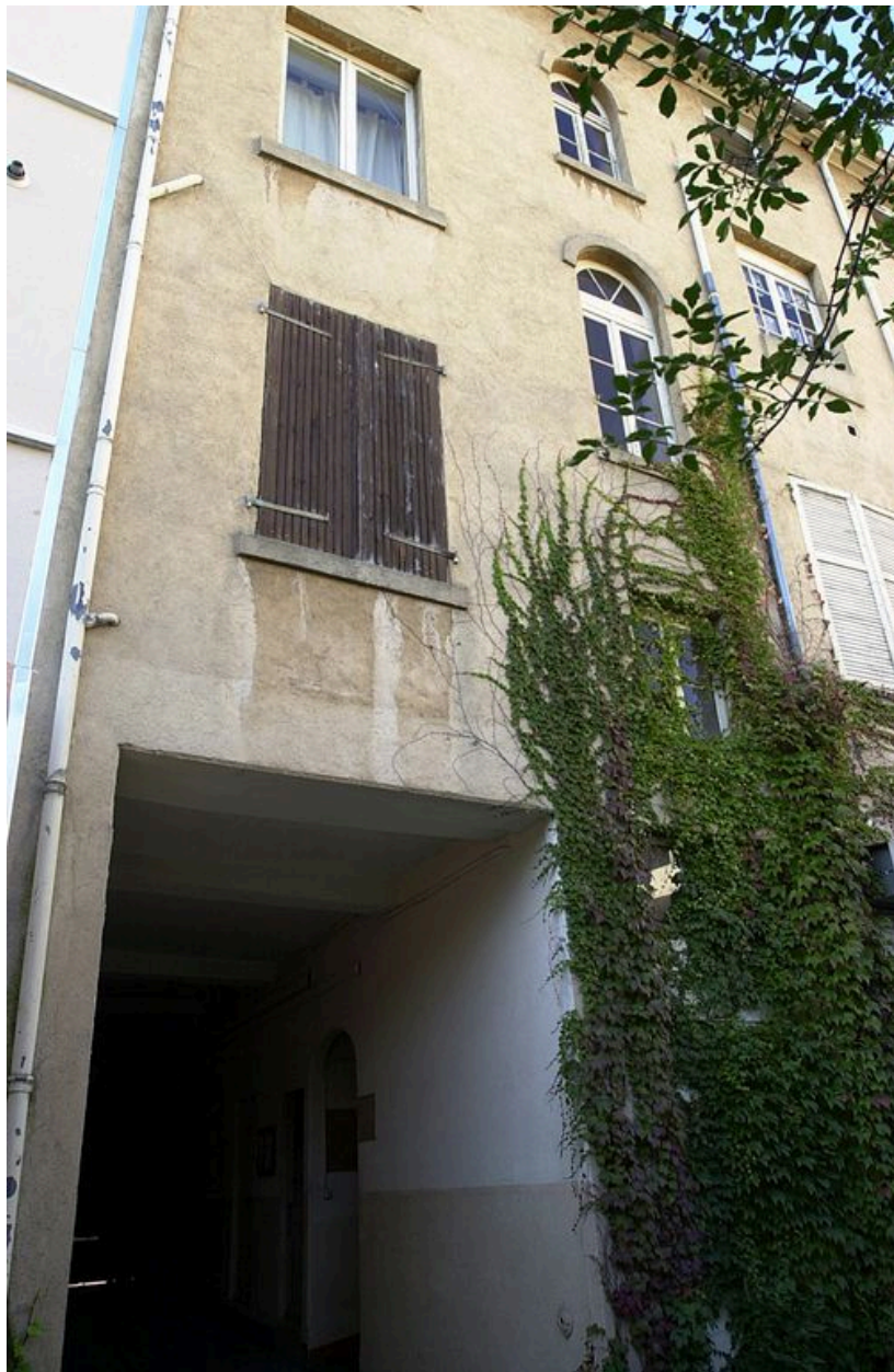
Elévation postérieure (partie)
