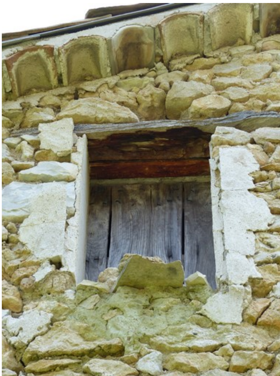
Pignon sud, troisième niveau. Fenêtre de la chambre puis séchoir.
