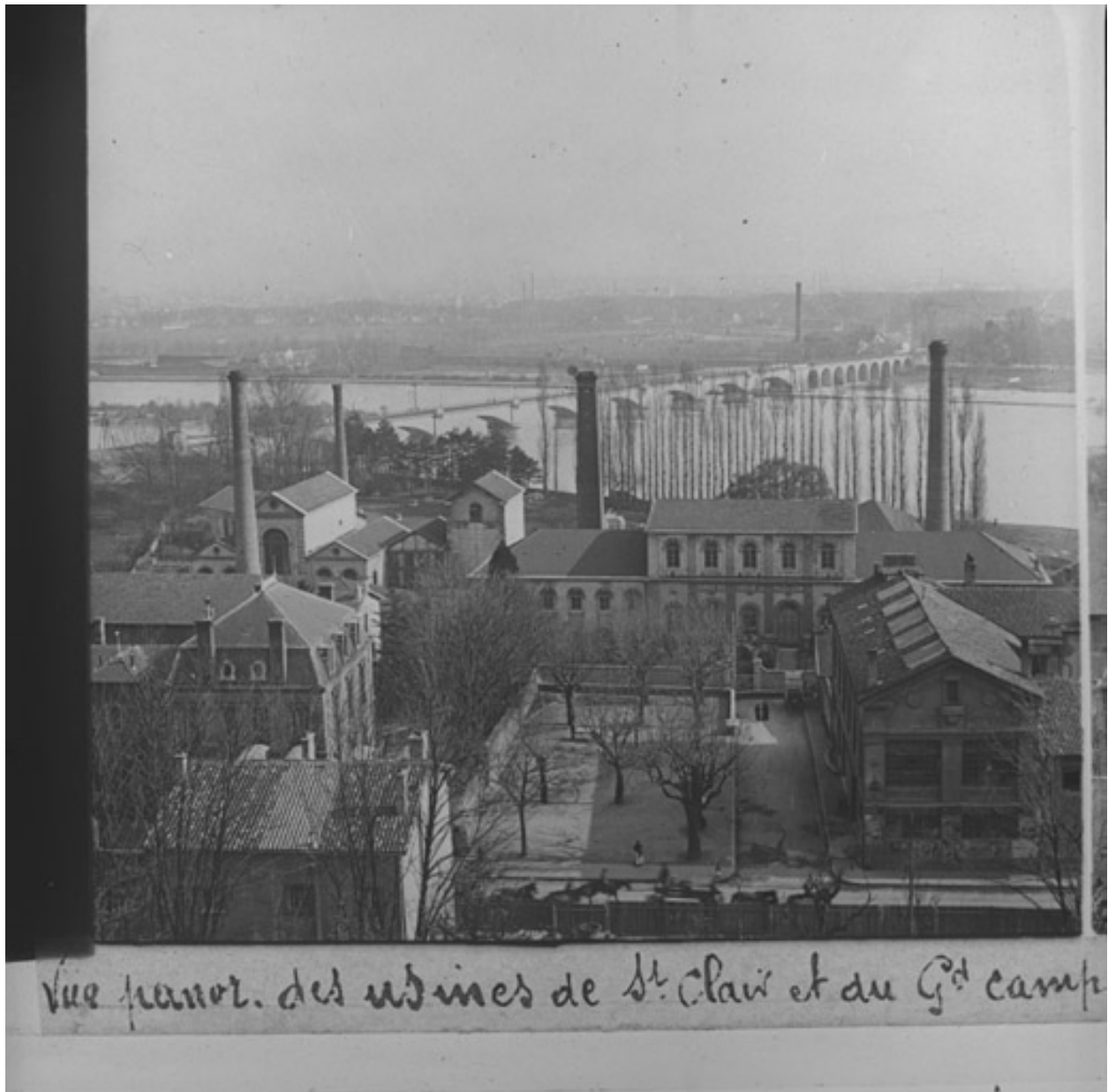
Vue panoramique des usines de St-Clair (Cie générale des eaux)
