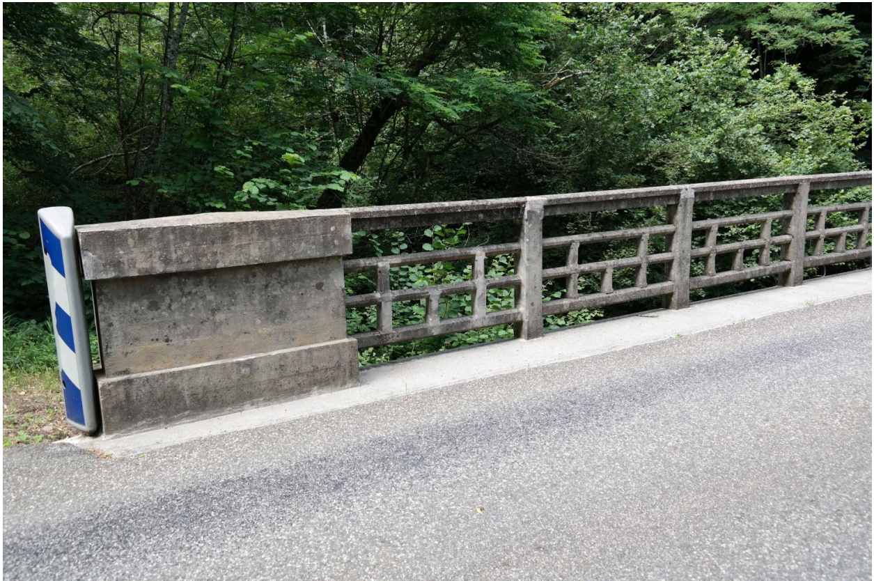
Pont du Parmand 1, détail des garde-corps en béton
