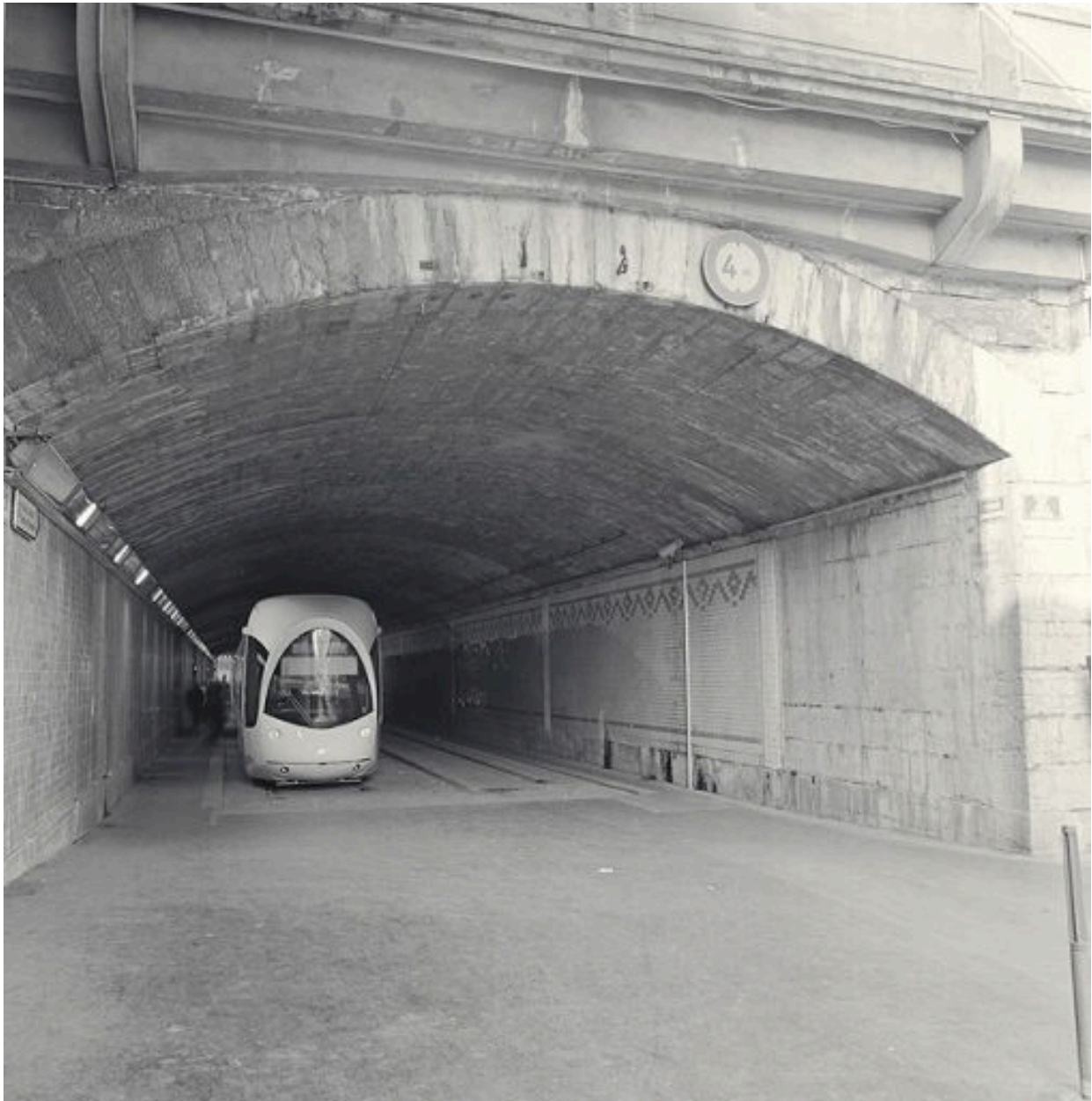
Vue du passage couvert ('voûte') côté Rhône
