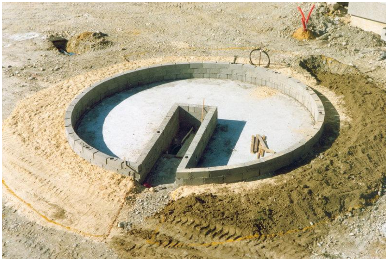
L'intallation extérieure en cours de réalisation, vue n°1 (phot. M. Papapietro)
