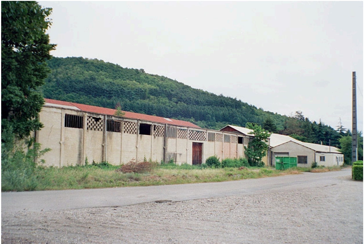
Vue générale. Façade est avec aérateurs
