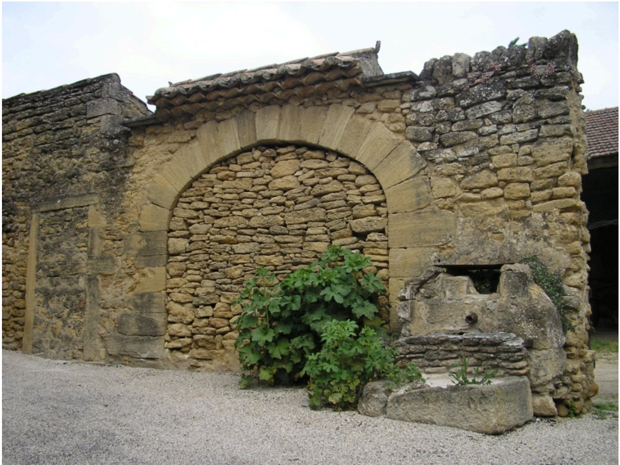
Margerie, la Placette, vue depuis le sud d'un porche muré et du puits communal.
