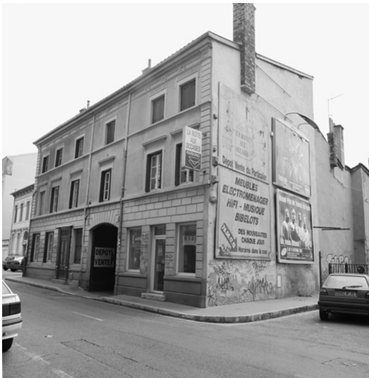
Vue générale nord
