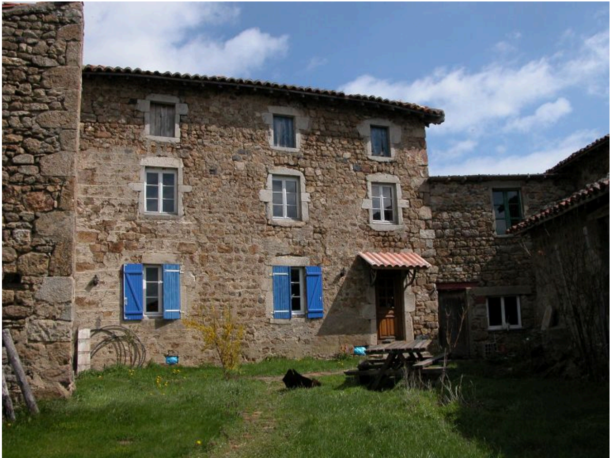
Vue d'ensemble du logis de la ferme, parcelle 632.
