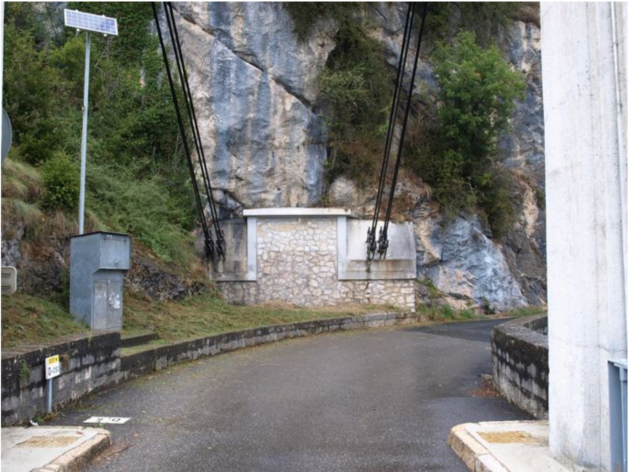
Massif d'ancrage et débouché en rive droite (depuis le pont)
