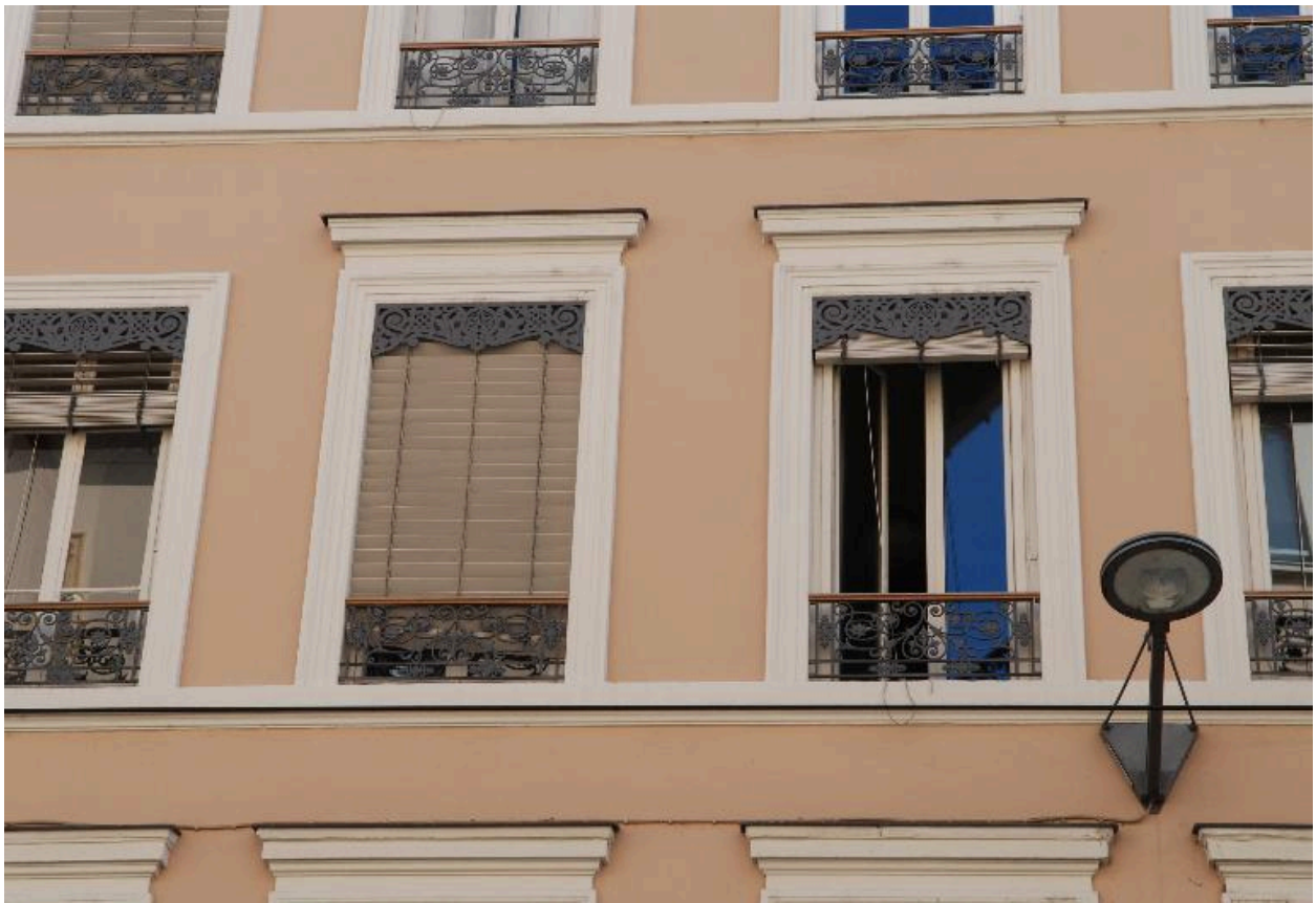
Détail du décor des baies centrales, au deuxième étage
