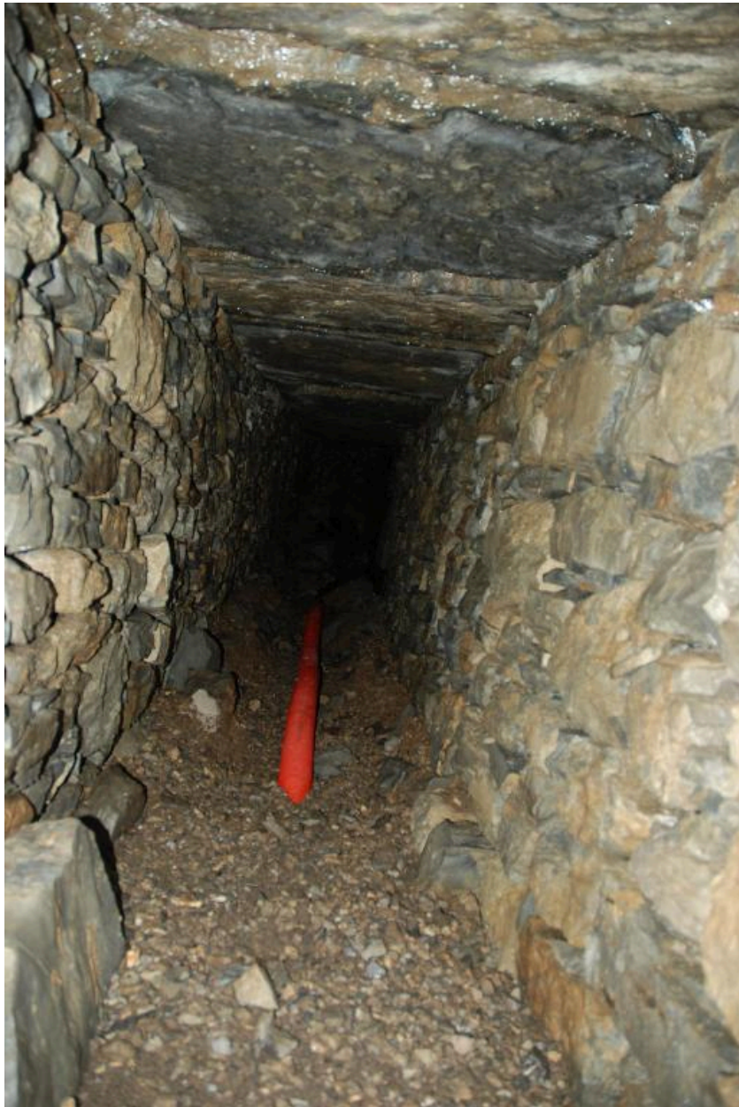
Prise d'eau aux Arbets (alpage de l'Arclusaz) : le couloir, vue en direction du fond.
