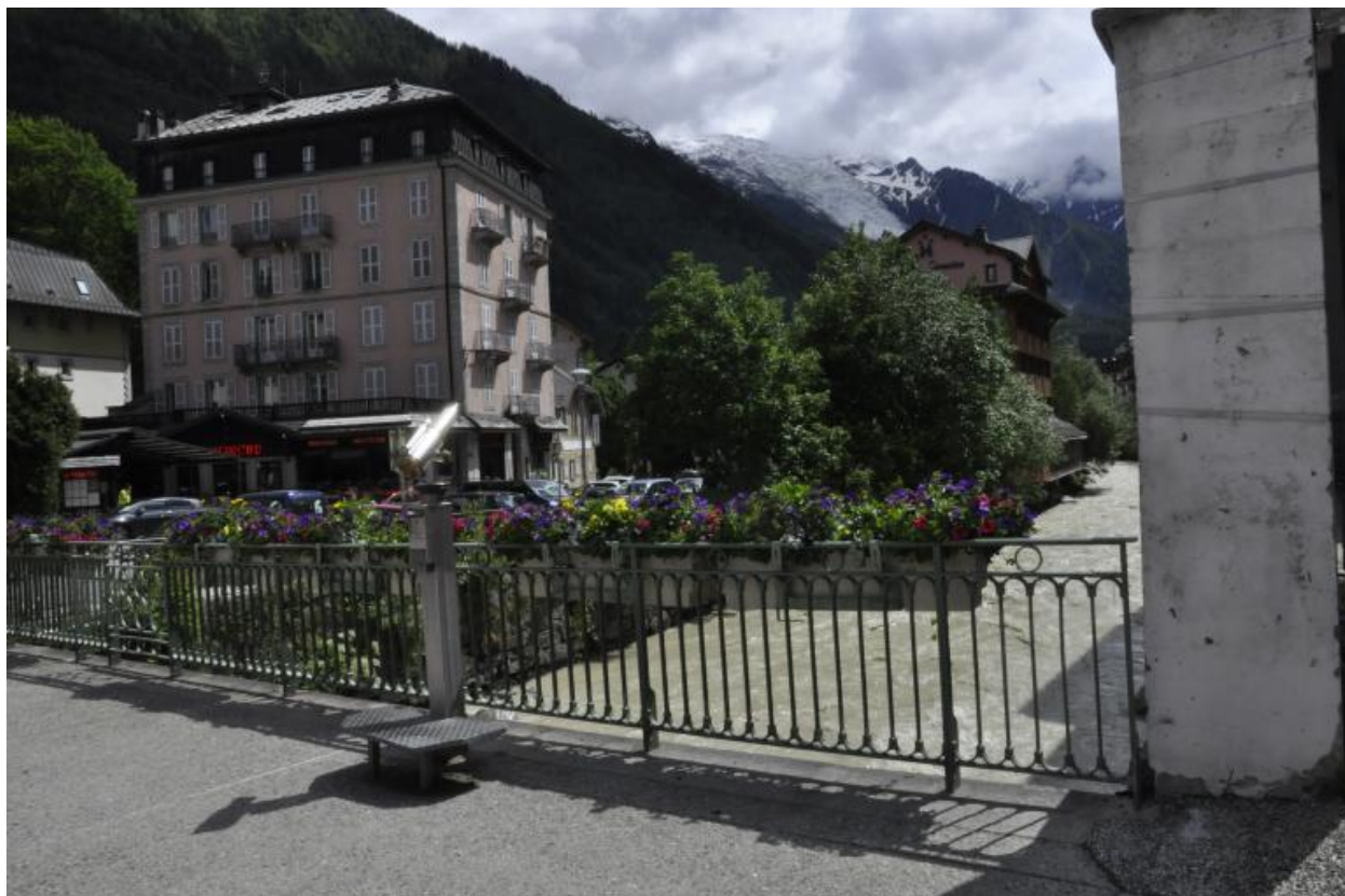
Garde-corps en face aval
