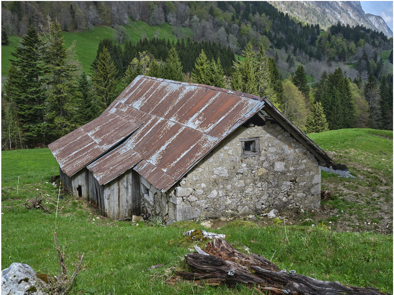
Vue de trois-quarts amont avec le pignon maçonné.
